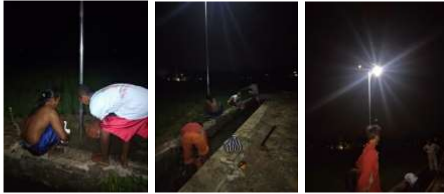
Gambar 5. Pemasangan lampu di Desa Sidakangen
