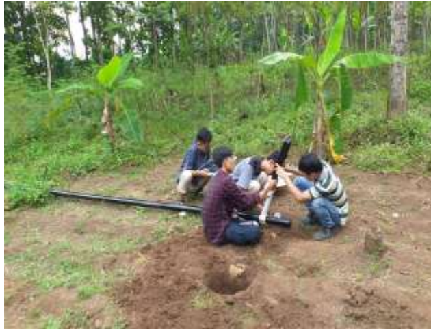
Gambar 8. Proses instalasi lampu PJU tenaga surya
