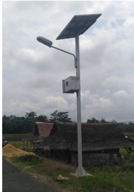
Gambar 2. Contoh lampu PJU energi surya
